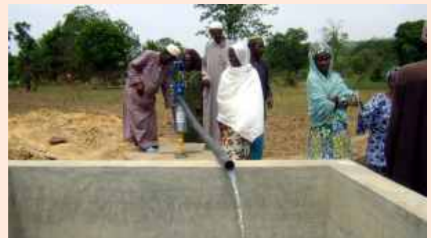
une pompe d'irrigation avec son bassin
