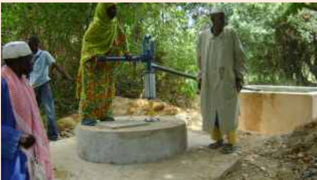
une pompe d'irrigation avec son bassin
